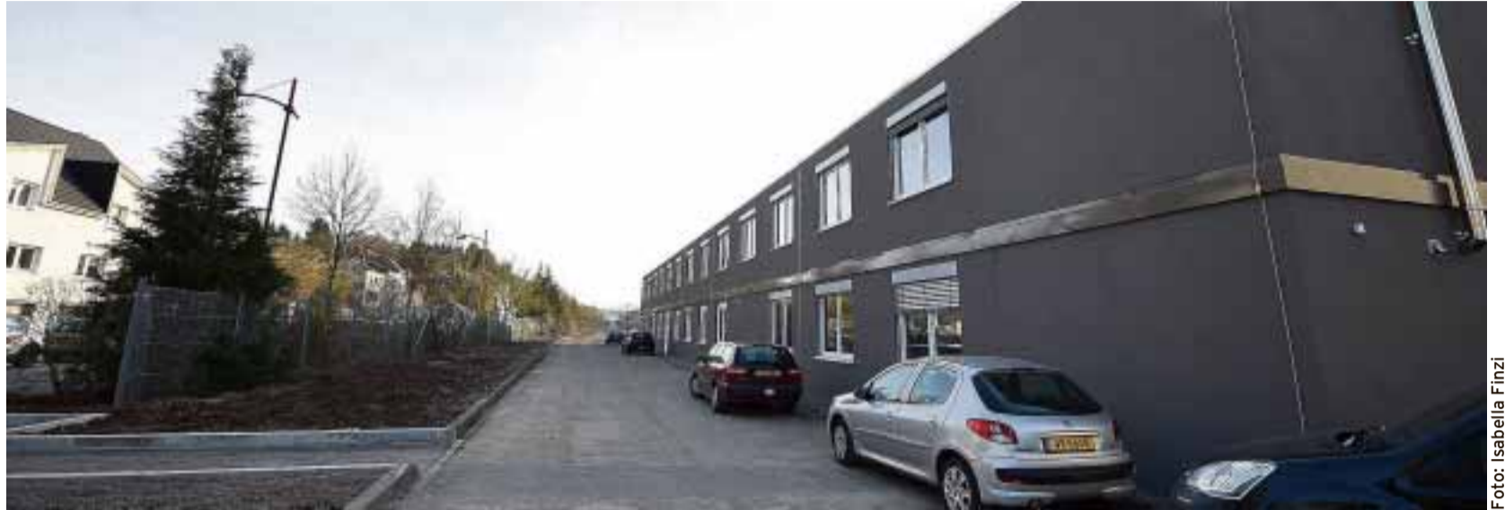
Das Flüchtlingsheim befindet sich auf der ArcelorMittal-Brache in der rue de Volmerange
