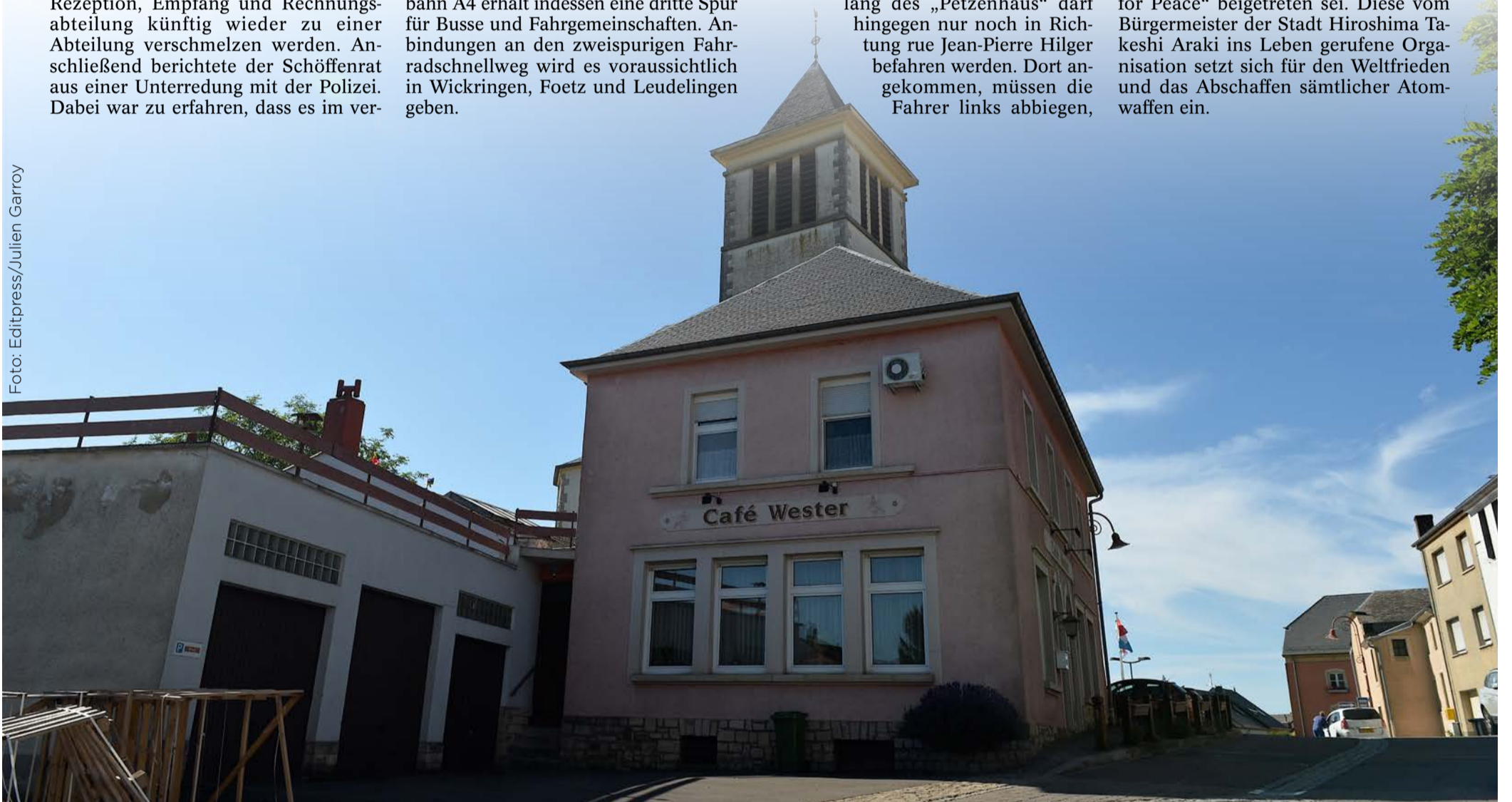
Im Dorfkern von Reckingen/Mess müssen sich die Einwohner auf einige Änderungen im Verkehr einstellen. Anlass sind die Bauarbeiten an der neuen „Maison relais“.
