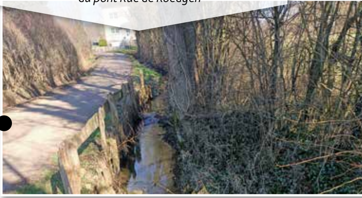
Création d'un mur anti-crue en amont du pont Rue de Roedgen
