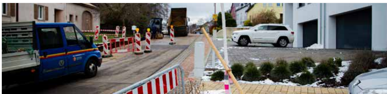
D'Rue de la Montée zu Reckeng, Enn Januar 2023: Ufank vum Chantier fir d'Erneierung vun der Kanalisatioun. / La rue de la Montée à Reckange, fin janvier 2023: Début du chantier portant sur le renouvellement de la canalisation.
