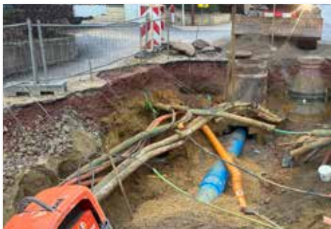
Installatioun vun den Netzwierker (lénks) an d'Strooss mam provisoiresche Binder. Installation des réseaux (gauche) et application du binder provisoire.
