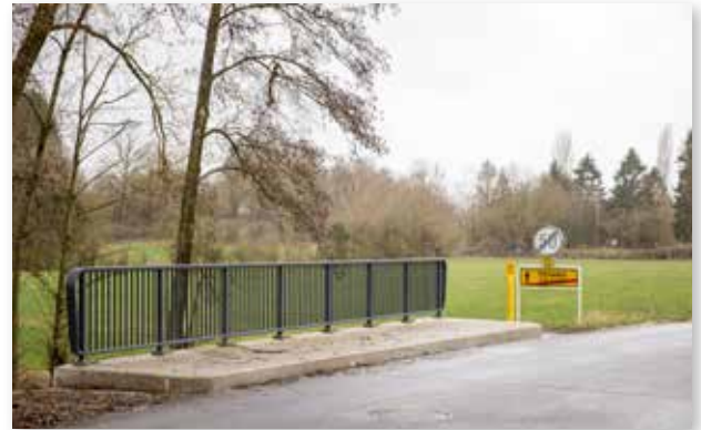
Hei kënn den zukünftege Réckhaltebecken hin. L'emplacement du futur bassin de rétention d'eau.
