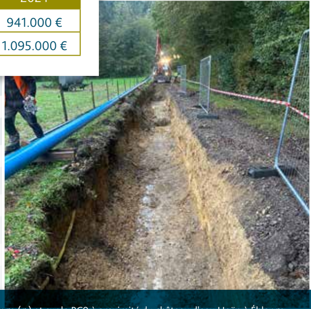
Renouvellement des conduites d'eau sur le sentier entre Reckange et Ehlinge (g.) et sur le PC9 à proximité du château d'eau Hoën à Éhlinge.
