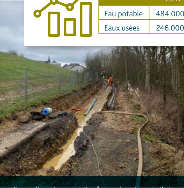
Renouvellement des conduites d'eau sur le sentier entre Reckange et Ehlinge (g.) et sur le PC9 à proximité du château d'eau Hoën à Éhlinge.
