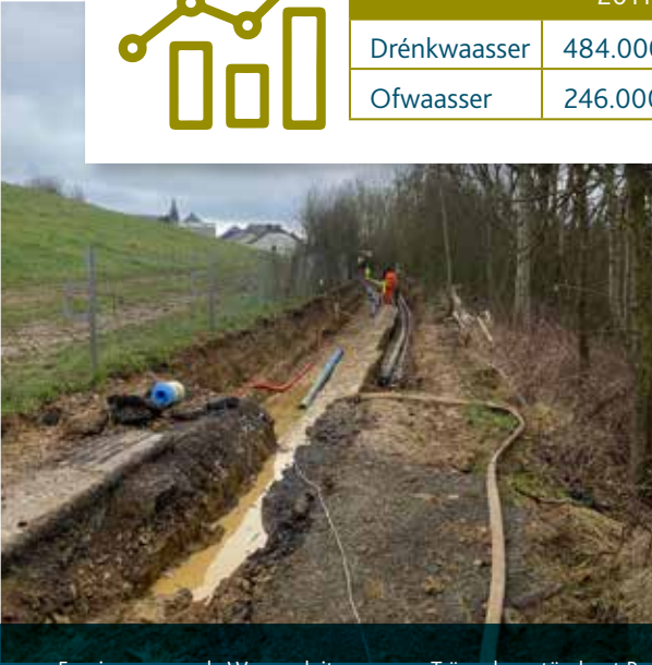
Erneuerung vun de Waasserleitungen um Tréppelwee tëschent Reckeng an Éileng (L.) an um PC9, onwäit vum Waassertuerm Hoën zu Éileng.
