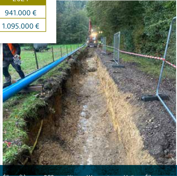
Erneuerung vun de Waasserleitungen um Tréppelwee tëschent Reckeng an Éileng (L.) an um PC9, onwäit vum Waassertuerm Hoën zu Éileng.
