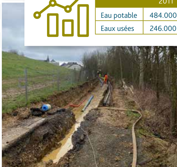
Renouvellement des conduites d'eau sur le sentier entre Reckange et Ehlange (g.) et sur le PC9 à proximité du château d'eau Hoën à Éhlange.
