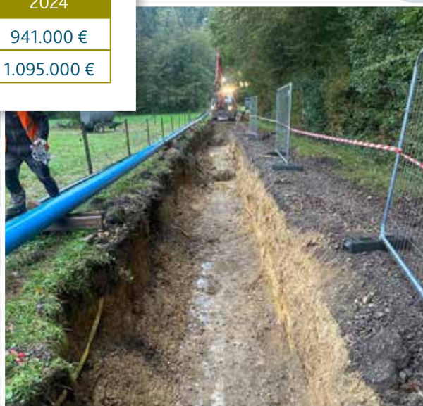
Erneuerung vun de Waasserleitungen um Tréppelwee tëschent Reckeng an Éileng (L.) an um PC9, onwäit vum Waassertuerm Hoën zu Éileng.
