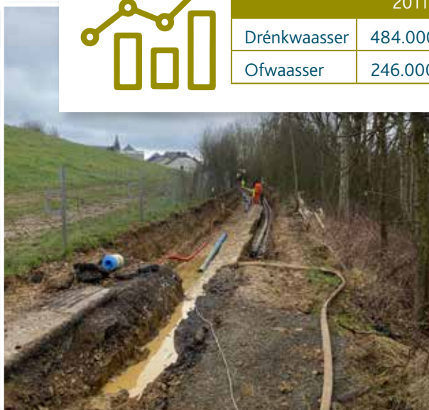
Erneuerung vun de Waasserleitungen um Tréppelwee tëschent Reckeng an Éileng (L.) an um PC9, onwäit vum Waassertuerm Hoën zu Éileng.
