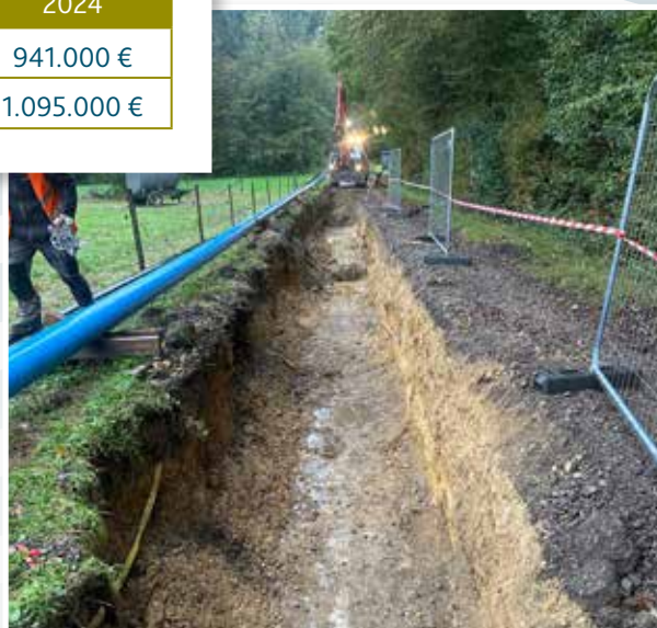
Renouvellement des conduites d'eau sur le sentier entre Reckange et Ehlange (g.) et sur le PC9 à proximité du château d'eau Hoën à Éhlange.
