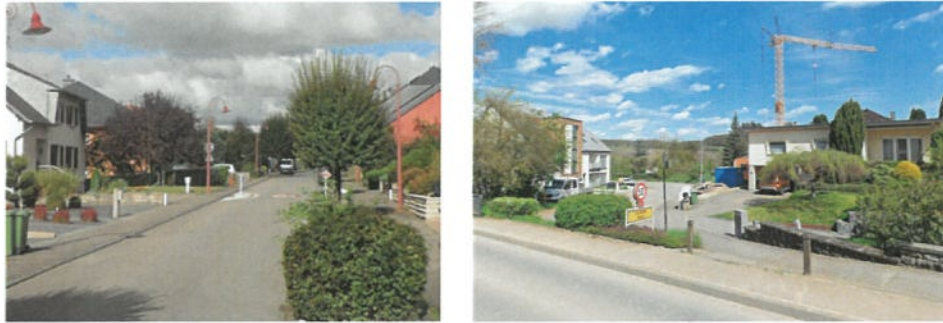
Verkehrsberuhigungsmaßnahmen (Pflanzinseln, Berliner Kissen) im Bereich der rue du centre in Ehlang (links) und am Übergang Wickrange-Ehlang (Schließung der ehemaligen PKW-Zufahrt von der N13 zur „rue du Centre“ durch bauliche Maßnahmen/ Poller - rechts). Quelle: IGLux, 2026
