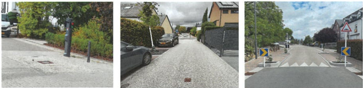
Verkehrsberuhigungsmaßnahmen im Bereich des Schulcampus: Versenkbare Poller Rue Kamerich (links), T20 und heller Belag rue Kamerich (mitte), Plateau vor der Schule an der „rue de la Montée“ (rechts). Quelle: IGLux, 2026
