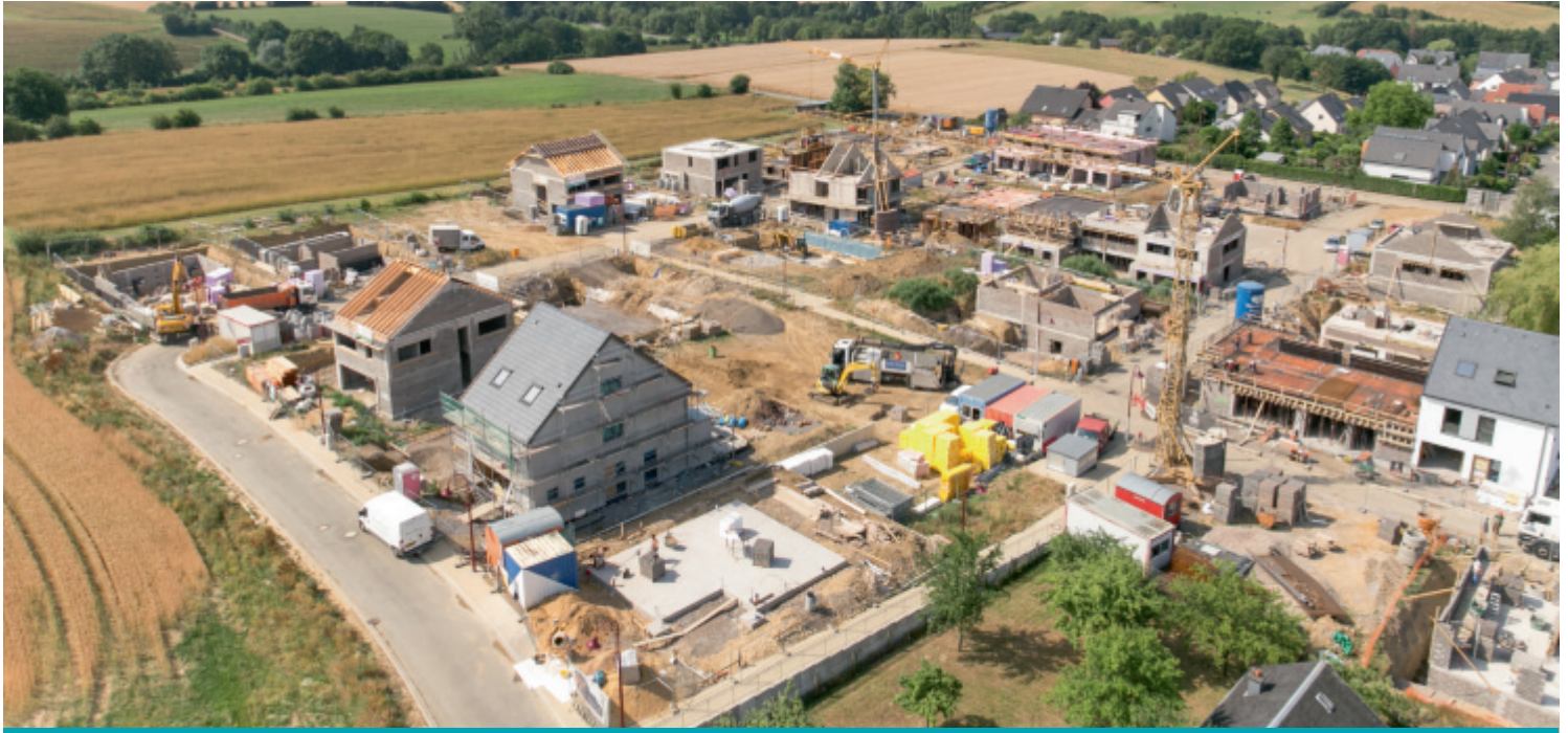
Baustelle der Wohnsiedlung „Kleng Lehm“ in Reckingen/Mess. Aufnahme vom 17. Juli 2015.
