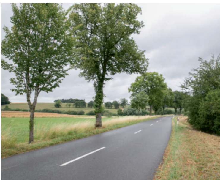
Am 31. August beginnen die Arbeiten am CR 172
