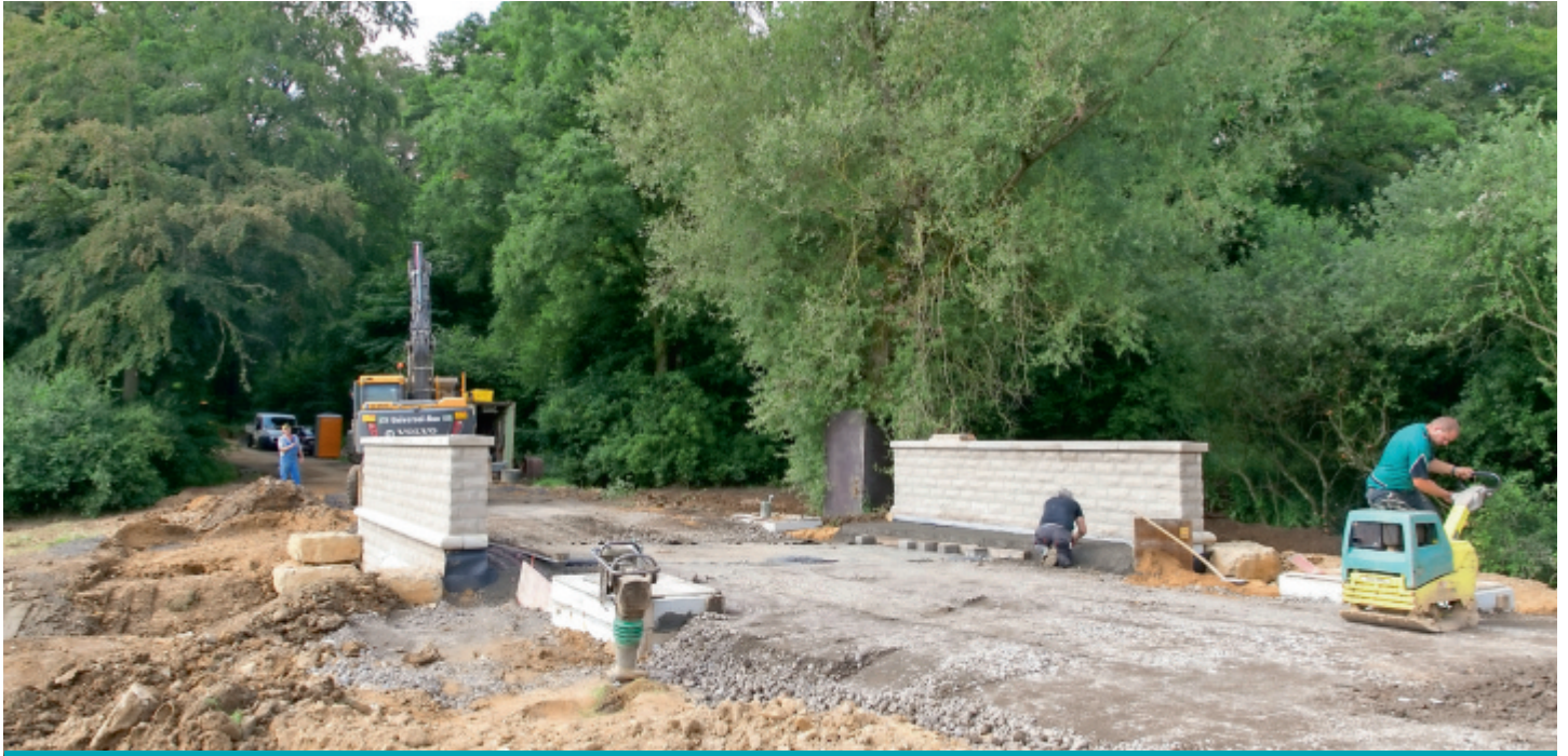
Die Arbeiten am CR 106 zwischen Limpach und Monnerich liegen im Zeitplan. Die Freigabe für den Verkehr soll Anfang Oktober erfolgen.
